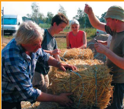
Pressen, nähen, stopfen – das Strohballenhaus in Leiferde.
